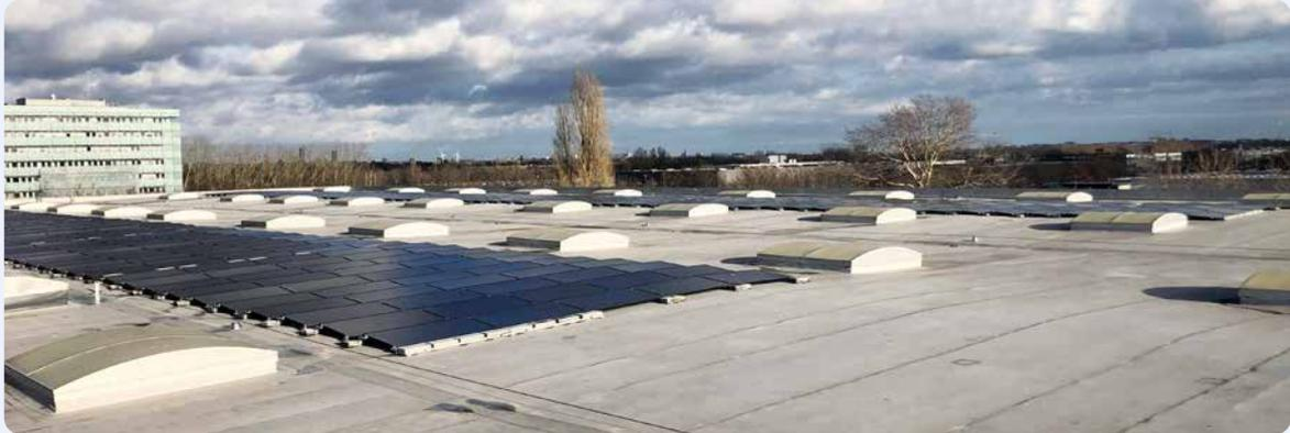
Mitten in der COVID-19 Krise weihte Bossard Dänemark im Mai 2020 eine Photovoltaikanlage (PV-Anlage) auf dem Dach ihres Gebäudes ein. 735 Solarmodule haben im Jahr 2020 rund 220 MWh produziert und so zu einer Verringerung der Treibhausgasemissionen aus der Energieproduktion beigetragen. Der Himmel in Dänemark ist nicht immer klar, aber wenn die Sonne scheint, kann der Stromverbrauch unserer 80 Mitarbeitenden komplett durch Solarstrom vom Dach gedeckt werden.
