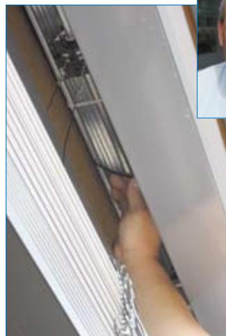
«Wichtig ist beim Montieren, dass der Kabelbinder auch lang genug ist, so kann man ihn einfädeln und das Motor-kabel noch ausrichten bevor der Kabelbinder endgültig angezogen wird.»
