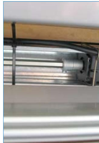
allem durch eine höhere Widerstandskraft gegenüber UV-Einstrahlung und durch den Temperaturbereich von -40 °C bis 85 °C aus. Die Firma Griesser, einer der führenden Storenhersteller Europas, hat dieses Problem früh erkannt und setzt deshalb die hitzestabilisierten und wetterbeständigen Kabelbinder aus Polyamid 6.6, schwarz (BN 20309, 4.8x368) ein.
